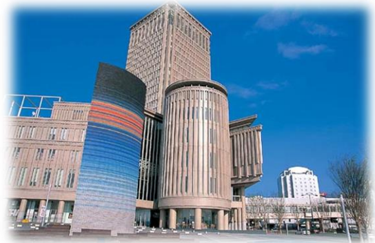
事務所がある霞城セントラルビル
